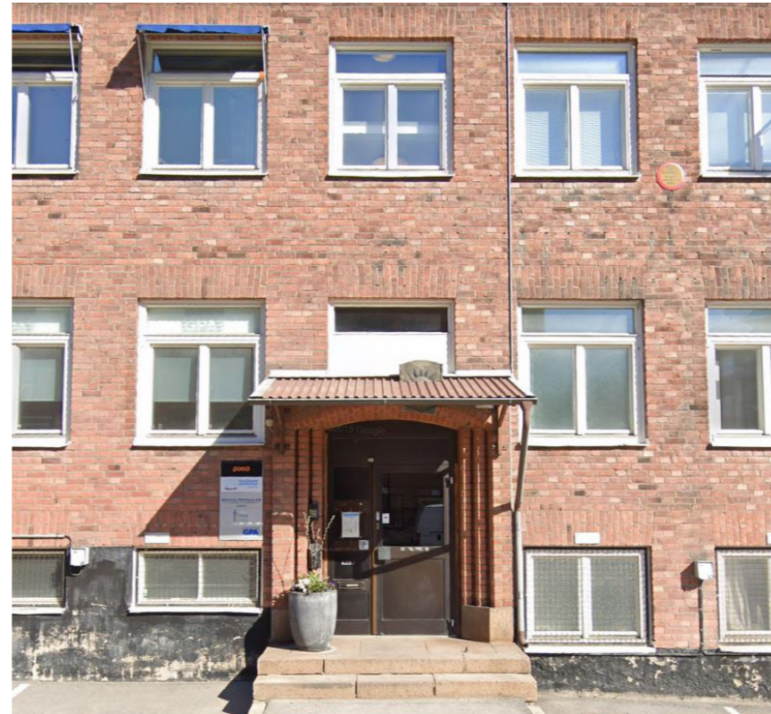
Återbruk av tegel från bef fasad, Kv Instrumentet 5, Solna Fotograf Brunnberg & Forshed arkitektkontor.
