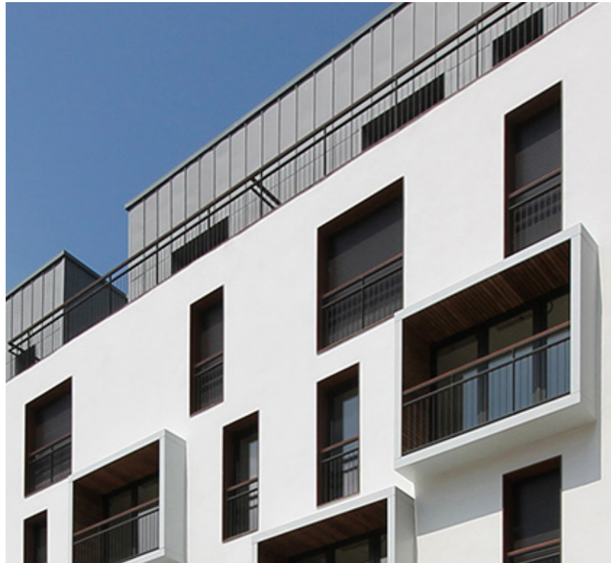
Trappning, indragen överbyggnad, Puts/Plåt Logements collectifs, ZAC Beaujon, Paris 8ème, Frankrike. Arkitekt: MDNH Architectes, Fotograf: Frédéric Delangle, Kamel Khalfi
