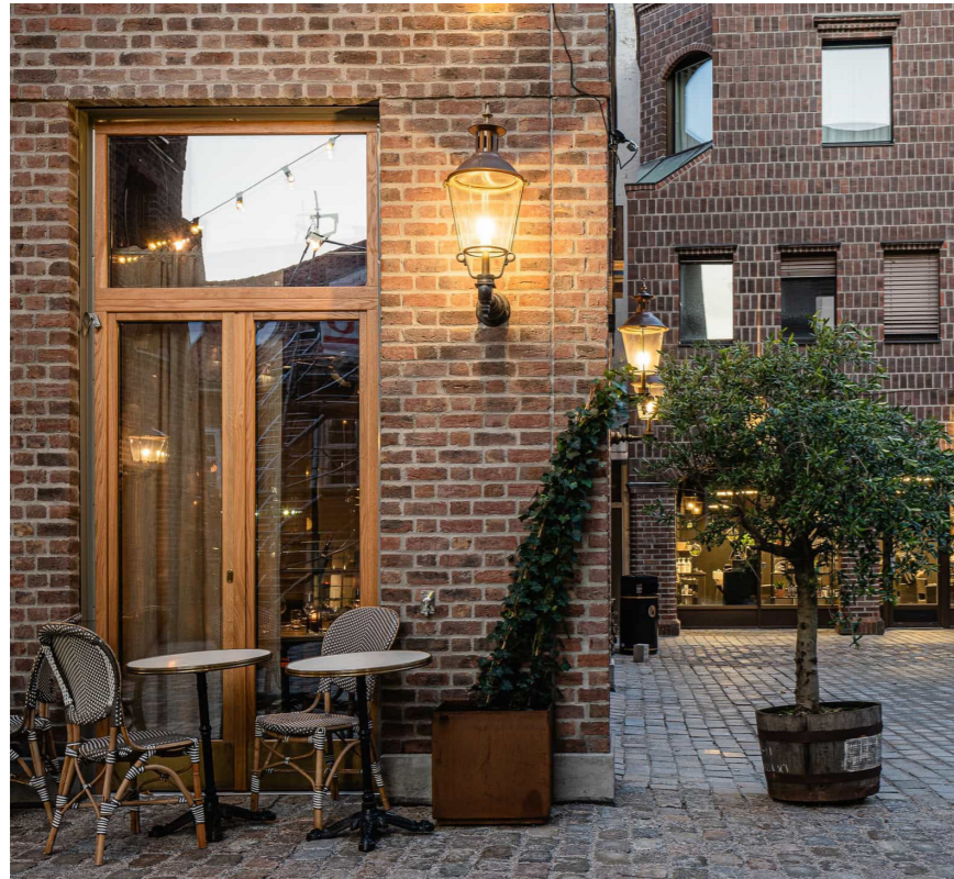
BV: Tegel / Granit / Glas i sockelvåning Nygaardsplassen, Fredrikstad, Norge. MAD arkitekter, fotograf Kyrre Sundal.
