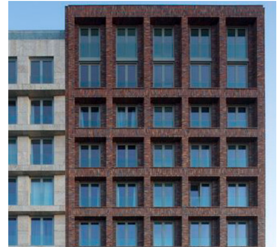
Tegel och struktur Indragna balkonger ger fasaderna djup Houthaven Blokk 0, Amsterdam, Nederländerna Arkitekt: MARCEL LOK_ARCHITECT, Fotograf: Arkitekten.
