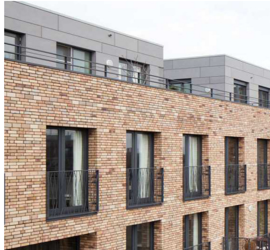
Trappning indragen överbyggnad, Tegel/Plåt De Halve Maen Apartment Building, Amsterdam, Nederländerna. Arkitekt: Mecanoo, Fotograf: Mecanoo
