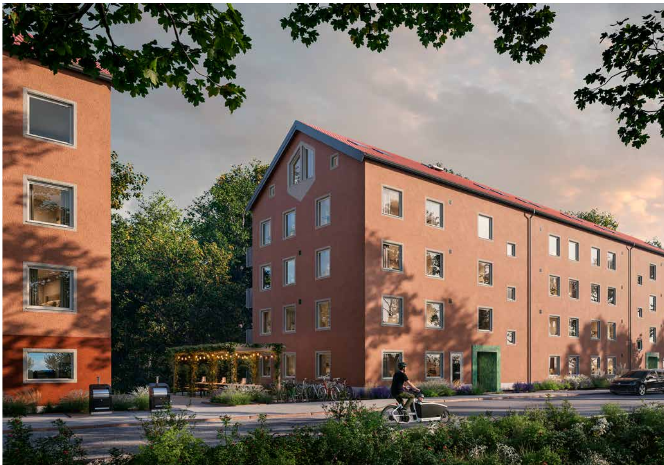
Innergården mellan husen bjuder på sittytor, planteringar, lektya och grillplats.
